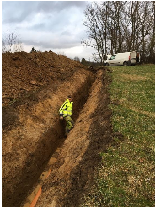
Bygget är igång – dräneringsdike!
